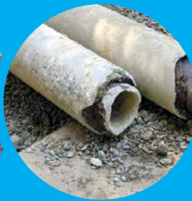
Asbestos Cement Pipes and Conduit
